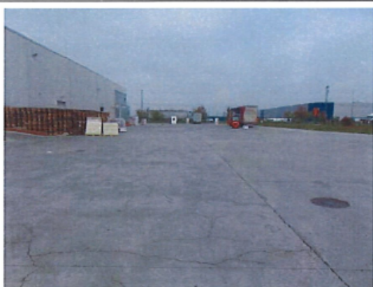
Constructii speciale: platforma betonata si imprejmuiri
