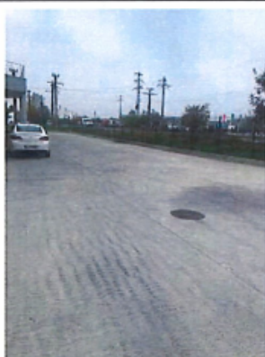
Constructii speciale: platforma betonata si imprejmuiri
