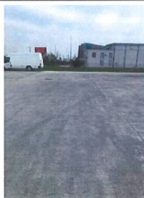
Constructii speciale: platforma betonata si imprejmuiri
