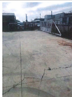
Constructii speciale: platforma betonata si imprejmuiri
