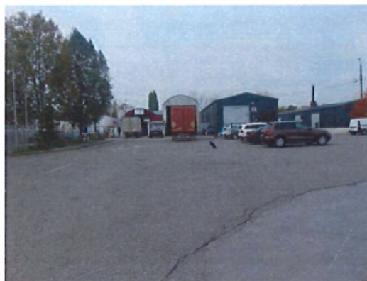
Constructii speciale: platforma betonata si imprejmuiri
